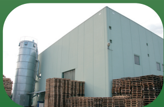
silos stoccaggio segatura
